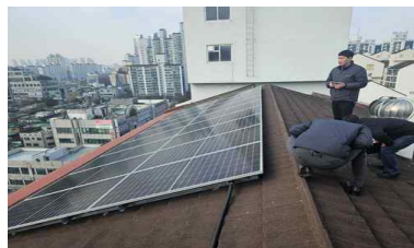
태양광 설치 지원
